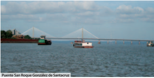
Puente San Roque González de Santacruz
